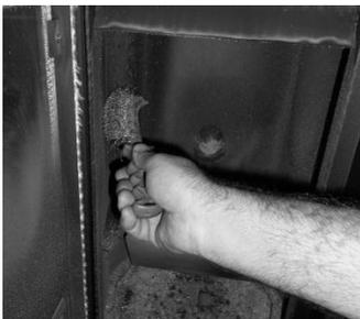
**Figura 51 - Limpeza do interior da salamandra a água**
