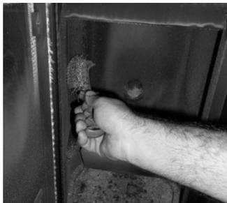
**Figure 51 – Nettoyage des turbulateurs**
