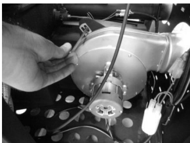
Figura 58 - a) Retirar los tornillos; b) Retirar el extractor
