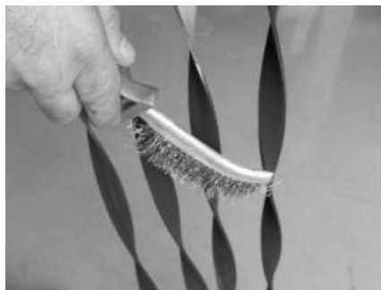
Figure 58 – Nettoyage des canaux de passage de gaz et turbulateurs
