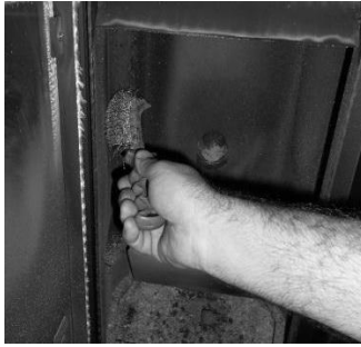
Figure 48 – Nettoyage intérieur poêle à granulés de l'eau
