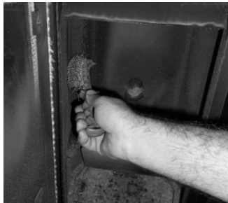
Figure 51 – Nettoyage des turbulateurs
