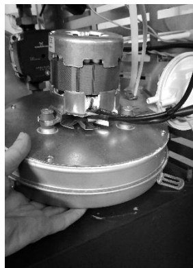
Figure 59 – a) Retirez les vis ; b) Retirez l'extracteur
