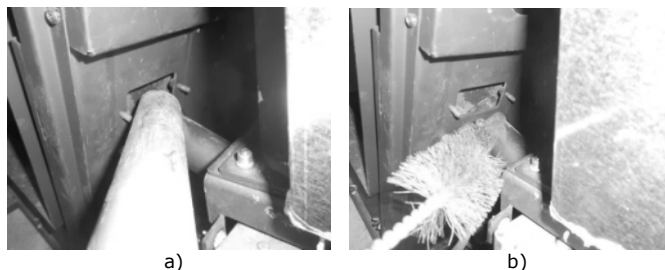
Figura 122 - a) Aspirar el interior; b) Limpiar con escobillón
