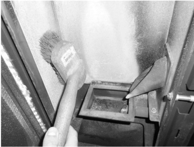
Figura 119 - Limpieza de la vermiculita
