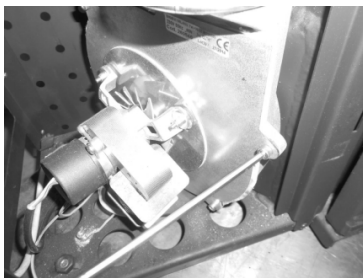
Figura 128 - a) Retirar los tornillos; b) Retirar el extractor
