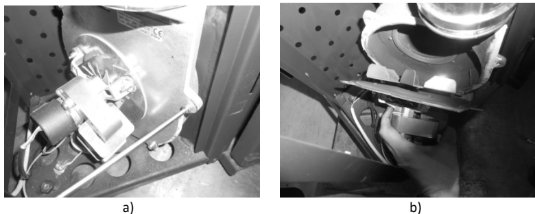
Figure 128 – a) Retrait vis ; b) Retrait extracteur
