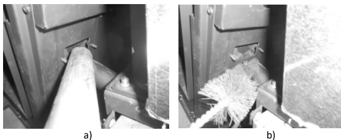
Figure 122 – a) Aspirer l'intérieur b) Nettoyage avec brosses
