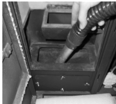
Figure 120 – Nettoyage intérieur du poêle
