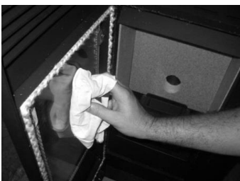
Figura 63 – Limpieza del vidrio: Limpiar el vidrio con el paño
