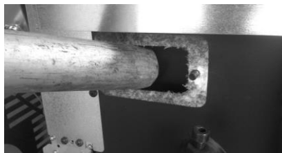
Figura 144 – Ejemplo K300, K400 a) Aspirar el interior; b) Limpiar con escobillón
