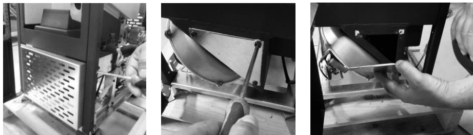
a) Desmontaje de la rejilla inferior b) Desmontaje de la tapa frontal c) Apertura frontal de la salida de humos
