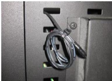
Figura 20- Sonda di temperatura ambiente
