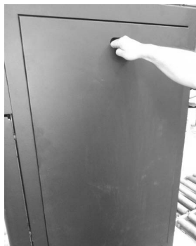
Figura 14 – Rimozione dei mantelli laterali
