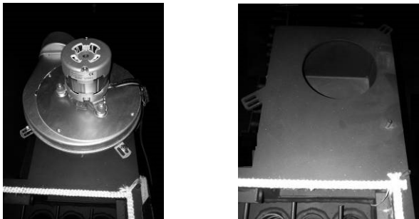
Figura 53 – Retirar os parafusos do extrator e aspirar a zona de passagem do ar
