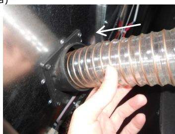
Figura 42 – Colocação do silo junto da caldeira (a); ligação do silo à cuba de pellets da caldeira (b e c)
