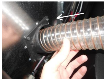
Figura 42 – Colocación del silo cerca de la caldera (a); conexión del silo al depósito de la caldera (b y c)
