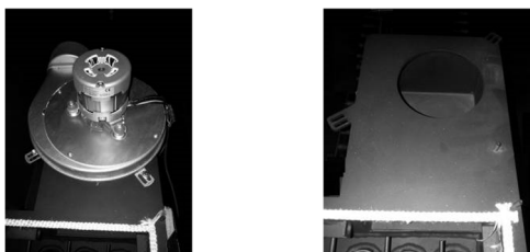
Figura 53 – Retire los tornillos del extractor y aspire la zona de paso del aire
