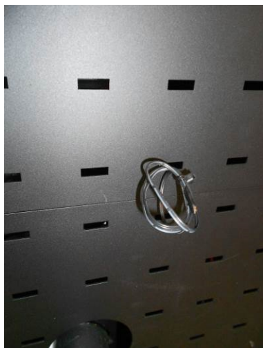
Figura 9 - Sonda de temperatura ambiente
