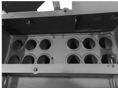
Figura 50 – Limpieza de los canales de paso de aire y turbuladores
