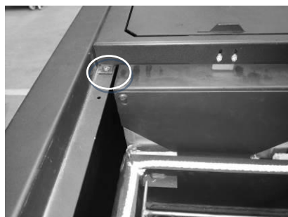
Figura 59– Rimuovere le viti del coperchio superiore, sulla parte anteriore e posteriore della caldaia, per accedere all'estrattore
