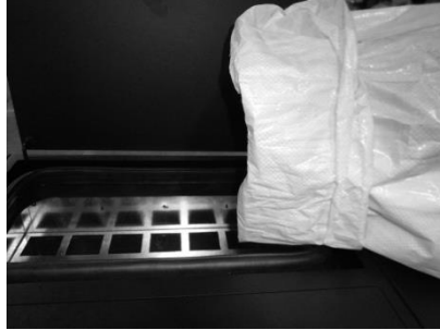
Figura 18 - Reabastecimiento del depósito de pellets
