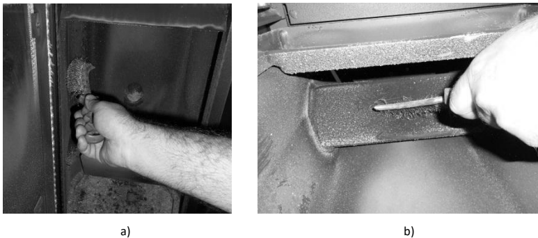
Figura 26 - Limpieza de interiores de la estufa agua
