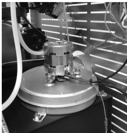
Figura 34 - a) Retirar los tornillos; b) Retirar el extractor
