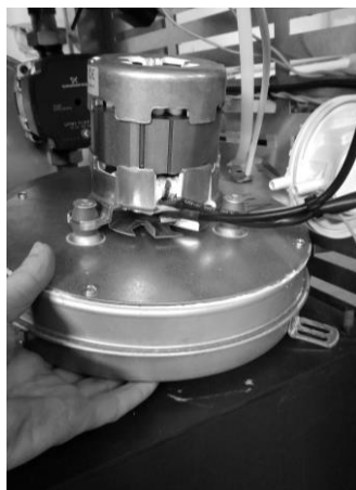
Figura 34 - a) Retirar los tornillos; b) Retirar el extractor
