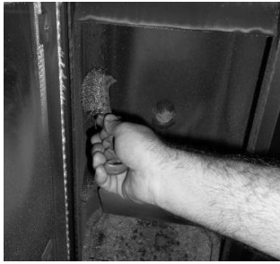
Figure 29 - Nettoyage de l'intérieur de la compacte à eau
