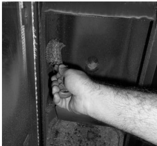
Figure 26 - Nettoyage de l'intérieur de la compacte à eau
