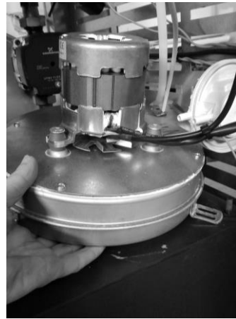
Figure 34 - a) Retirez les vis; b) Retirez l'extracteur
