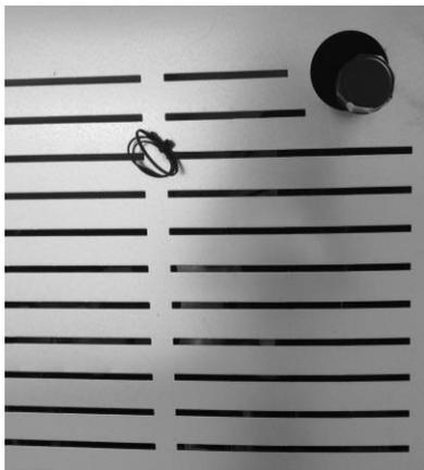
**Figure 13 - Sonde de température ambiante**
