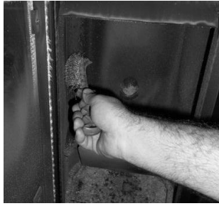
Figura 29 - Limpieza del interior de la compacta de agua
