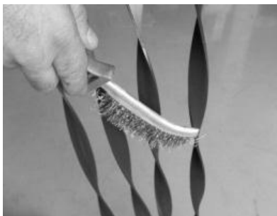
Figura 33 - Limpieza de los canales de paso de aire y turbuladores
