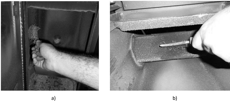
Figura 26 - Limpieza de interiores de la estufa agua
