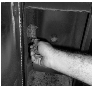
Figura 26 - Limpeza do interior da compacta a água
