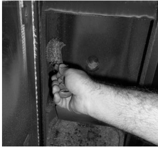
Figura 29 - Limpeza do interior da compacta a água
