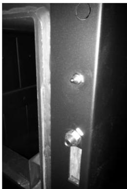
**Figure 2 - Microswitch placé sur le devant de la chaudière**
