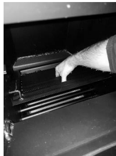
Figura 16 - Limpieza de la cámara de combustión
