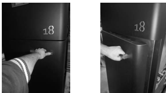
Figura 54 – Porta frontal da caldeira
