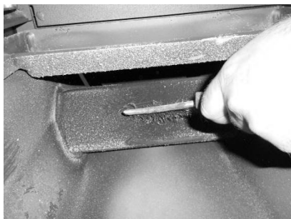
Figura 23 – Limpeza do interior da Caldeira a água
