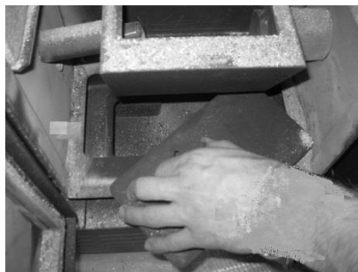
a) b) Figura 25 – limpeza do interior da Caldeira
