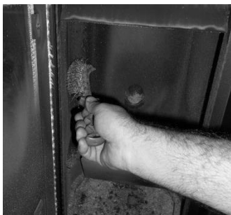
Figura 23 – Limpeza do interior da Caldeira a água
