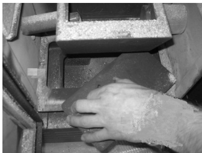
Figura 31 - Limpeza do interior da caldeira
