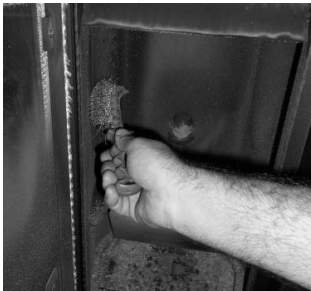
Figura 28 - Limpeza do interior da caldeira a água
