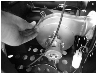
Figura 33 - a) Retirar os parafusos; b) Retirar extractor
