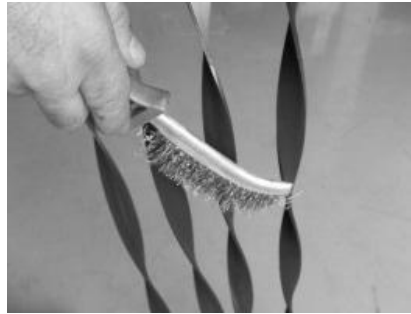
Figura 32 - Limpeza dos canais de passagem de ar e turbuladores
