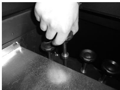
Figura 27 - Limpeza dos turbuladores
