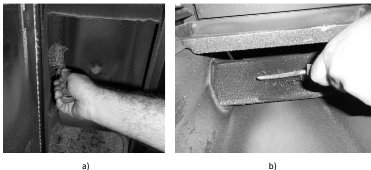
Figura 25 - Limpeza do interior da compacta a água
