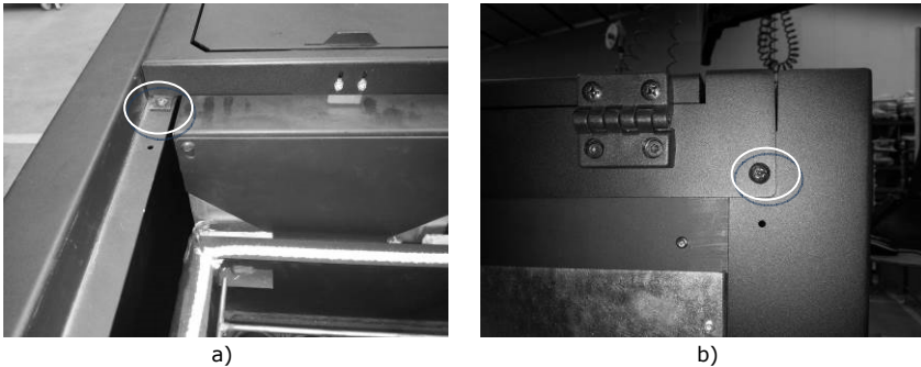
Figura 52 – Retirar os parafusos da tampa superior na parte da frente e na parte traseira da caldeira para ter acesso ao extrator
