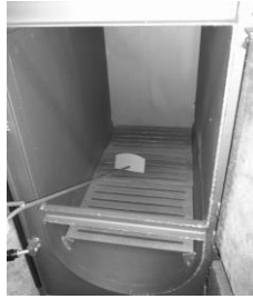
Figura 7 – Limpeza da câmara de combustão.
